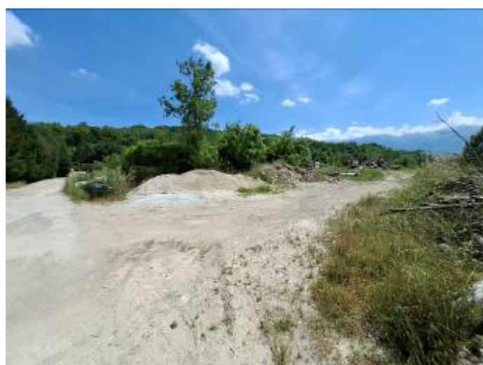
Immagine # 14 – Immagine stato di fatto – Tratto 05
